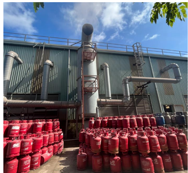
Hệ thống lọc bụi quá trình xử lý bụi từ máy phun bi xưởng mới
