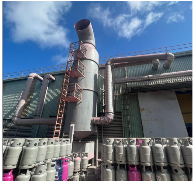
Hệ thống lọc bụi quá trình sơn sửa chai LPG xưởng mới
