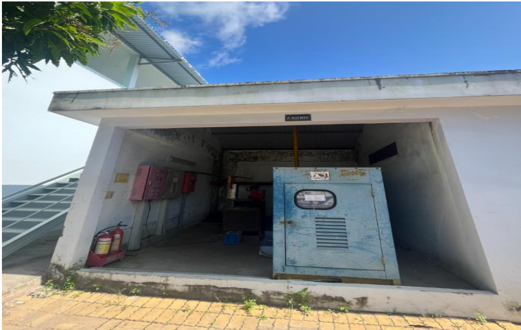
Hình 3.16: Nhà chứa máy phát điện của Xưởng
